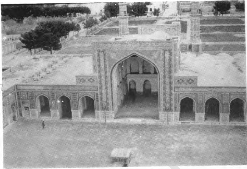
نمای شرقی مسجد جامع هرات .
